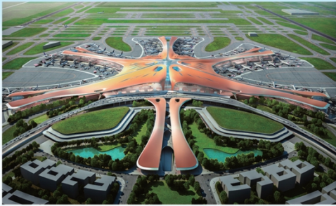
北京大兴国际机场
